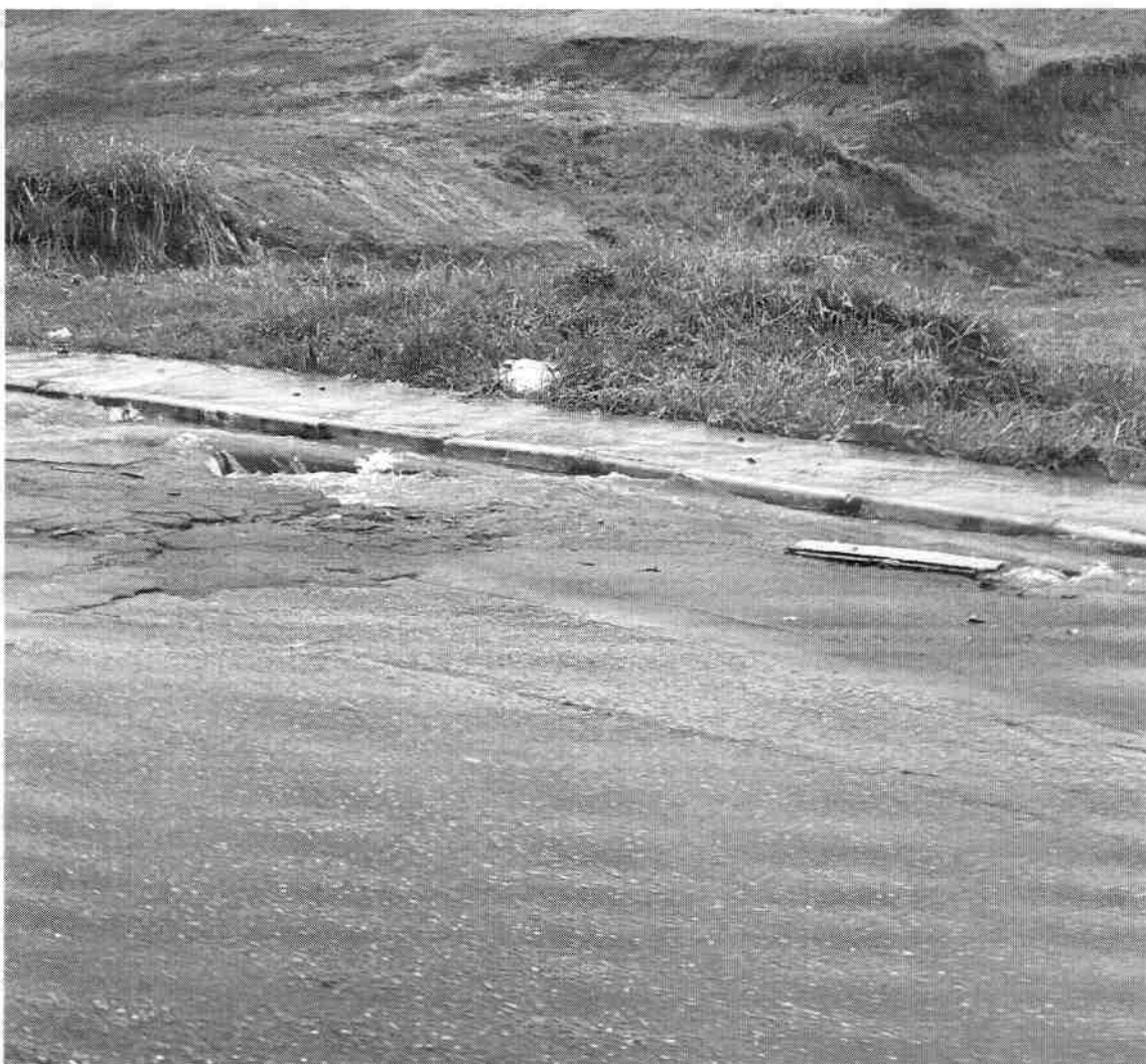
MANUTENÇÃO ASFÁLTICA EM TODA A EXTENSÃO DA RUA ANNA MACHADO DA COSTA, JARDIM ESPERANÇA- MOGI DAS CRUZES.
